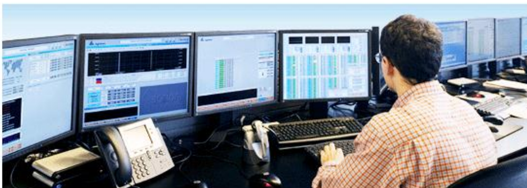
Fig. 4 Centro de Control de Energías Renovables (acciona energía.es)
